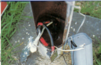
公園路燈燈柱管口防水處理
