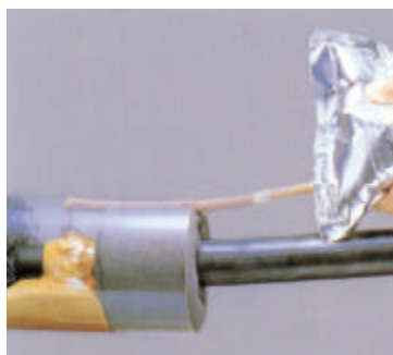
5. 發泡主劑之注入
