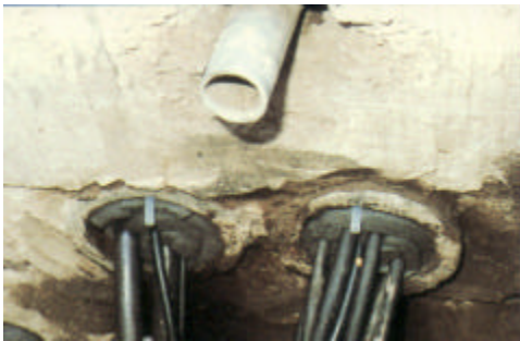
配電室地板管口防水處理
