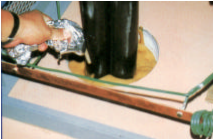
配電室地板管口防水處理
