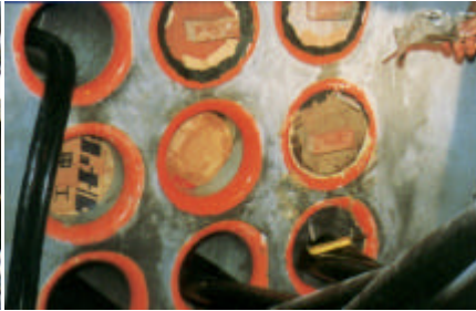
地下人孔內主牆管口之防水及預留管口堵塞處理
