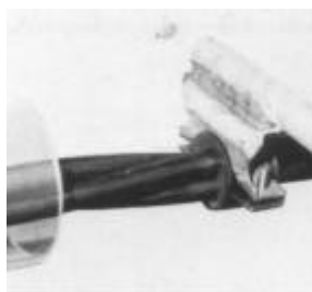
3. 將 CV-T 電纜解開之工具確實地裝設在距管路口約 150mm 處，其次搖動鐵棒使管口與托架間之電纜鬆開。
